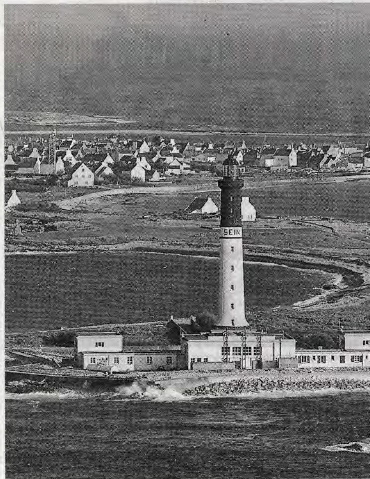
L'électricité est actuellement produite par des groupes électrogènes situés au pied du phare de l'île de Sein.
